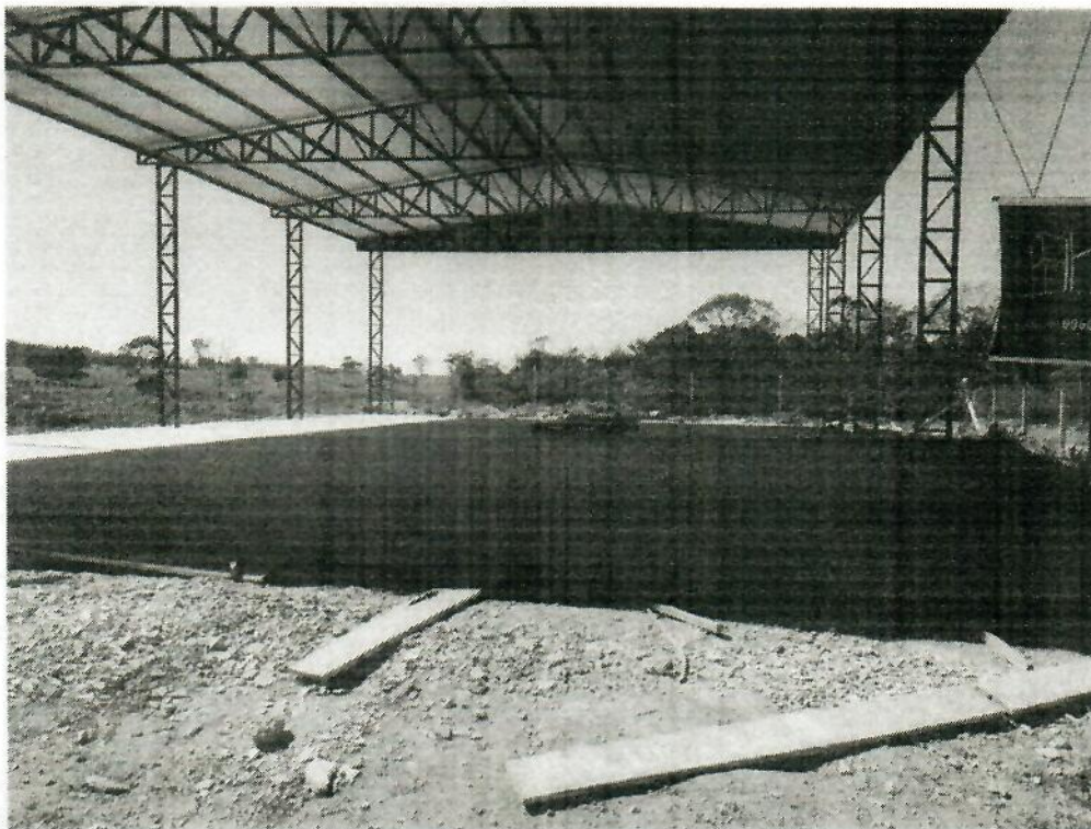
Imagem 03: Barracão finalizado com piso.
