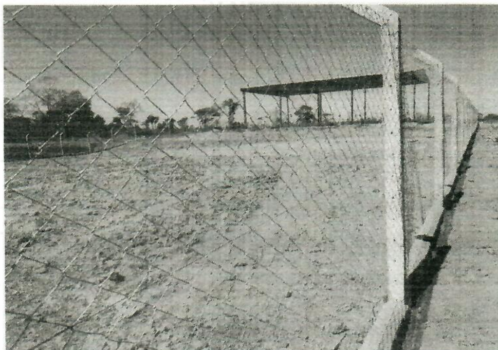
Imagem 02: Cerca construída para delimitar área.
